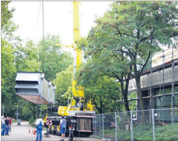
Die Lüftungs- und Klimatelemente mussten für die Zeit der Dachsanierung weichen.
