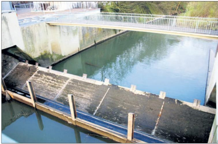
Die defekte Antriebsspinde am Hækkerwehr ist nach knapp vier Monaten repariert – das Wehr lässt sich wieder heben und senken. Das Herstellen der Ersatzteile an der mehr als 60 Jahre alten Anlage war eine diffizile Angelegenheit.
